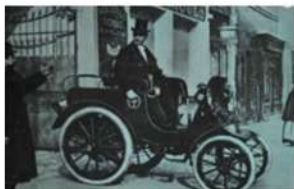
Automóvil eléctrico saliendo de un taller en New York donde se recargaban las baterías
